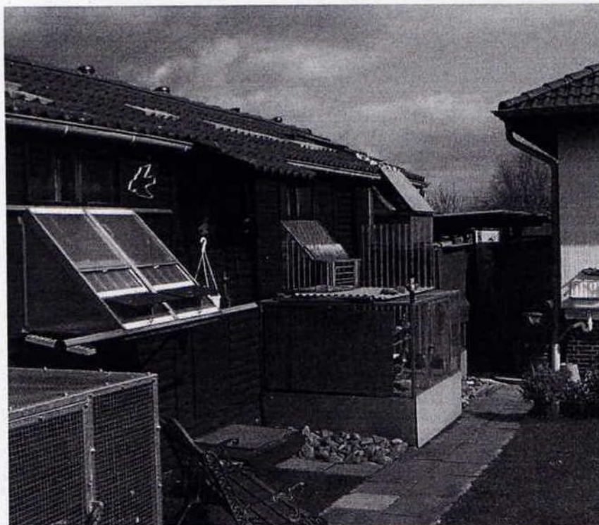
Außenansicht der Gottwald-Schlaganlage
